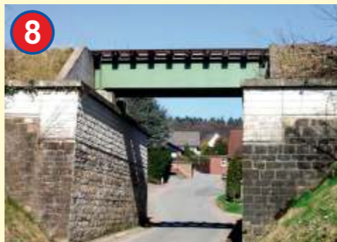
Eisenbahnbrücke mit Gleisbett in Heeßen
